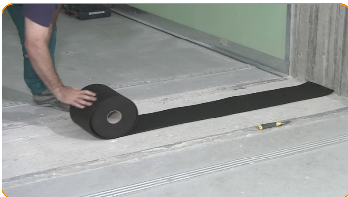
Ułóż izolację pod ścianą przed rozpoczęciem budowania.
