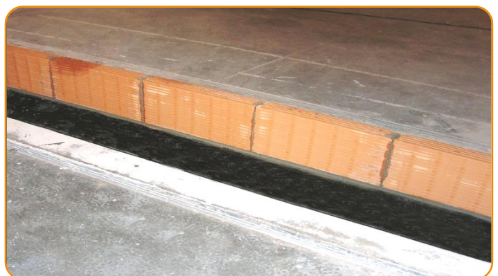
Zbuduj ściany nad izolacją pierwszego wprowadzenia go na łóżku zaprawy
