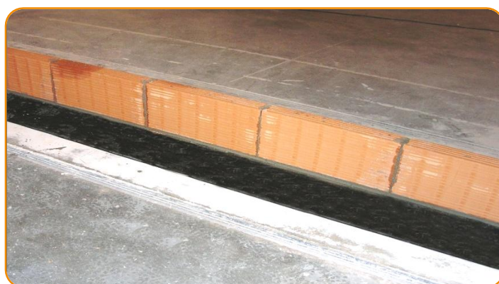
Zbuduj ściany nad izolacją pierwszego wprowadzenia go na łóżku zaprawy
