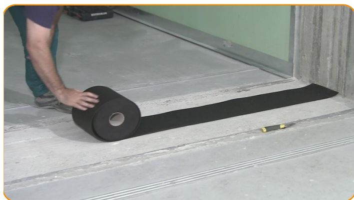
Ułóż izolację pod ścianą przed rozpoczęciem budowania.
