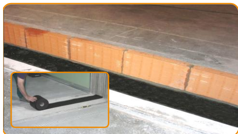
Ułóż izolację pod ścianą przed rozpoczęciem budowania.
