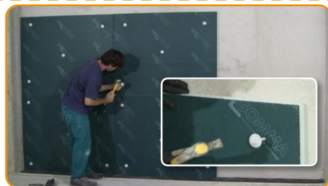
Przymocuj panel wbijając młotkiem 5 plastikowych kołków.
