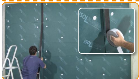
Po zamocowaniu wszystkich paneli, zaklej łączenia taśmą klejącą Stik.
