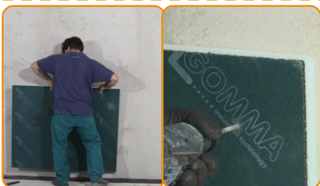
Przyłóż panel w odpowiednie miejsce na ścianie. Wykonaj pięć otworów w ścianie przewiercając panel (jeden otwór w środku panelu, 4 w jego narożnikach)
