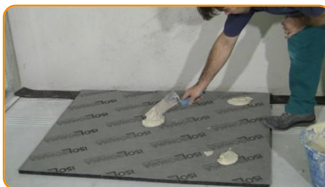
Nanieś i rozprowadź klej punktowo na panelu izolacji.
