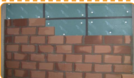
Postaw drugą ścianę starannie wypełniając zaprawą łączenia pionowe i poziome.
